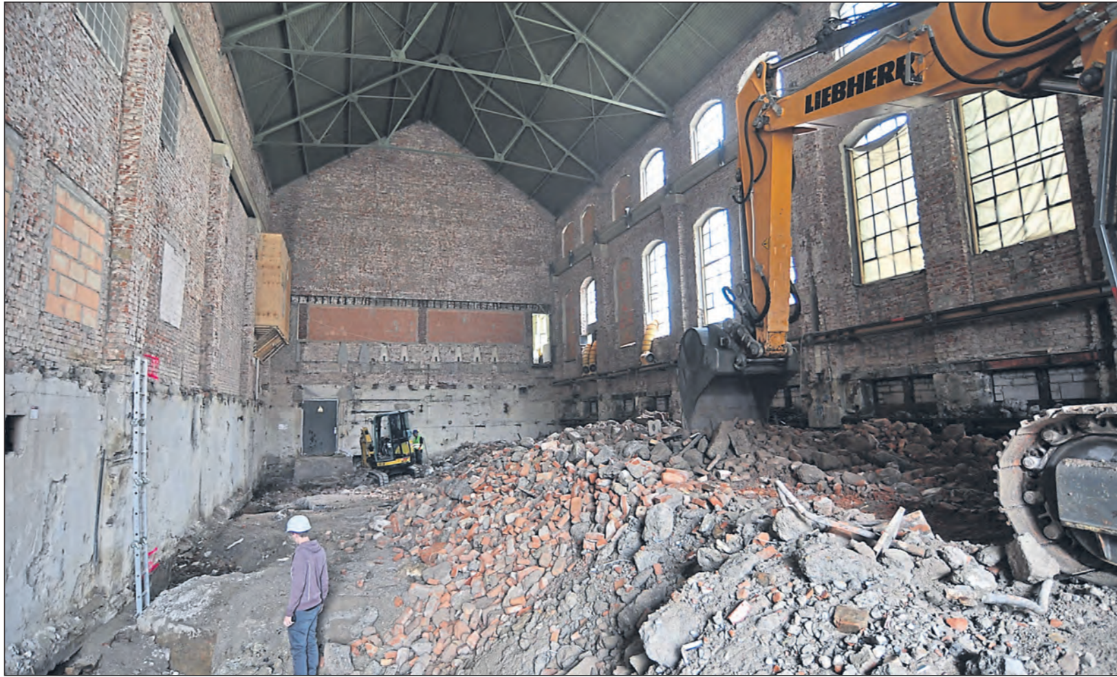
Abbrucharbeiten im Inneren des Bestandsgebäudes.
