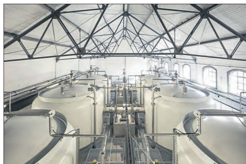
Die Aktivkohlefilterkessel nach Fertigstellung.
