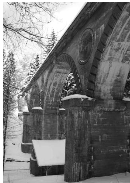
Bei der Teufelsgrabenbrücke handelt es sich um Stampfbetonaquädukt aus dem Jahr 1890. Foto: Holzer
