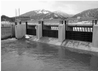
Blick auf einen Teil des Ableitungsbauwerkes. Foto: hau
