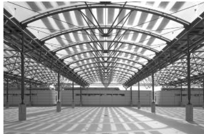
Der fertiggestellte Carport mit Solardach Foto: Büro Prof. Ackermann
