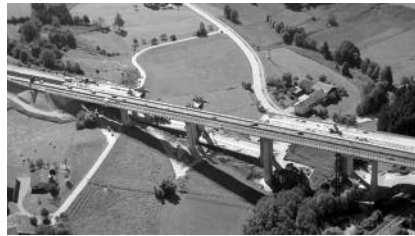
Umbaumaßnahmen Talbrücke Bergen Foto: HAUMANN + FUCHS
