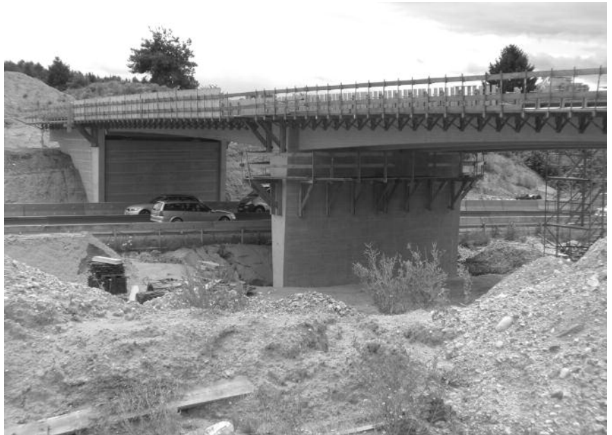
Mitten im Bau: Brücke über die A8
