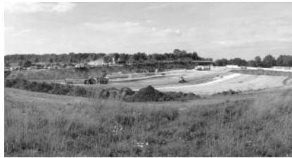
Hier entsteht die neue Arena Regensburg Foto: Dr. Weigl
