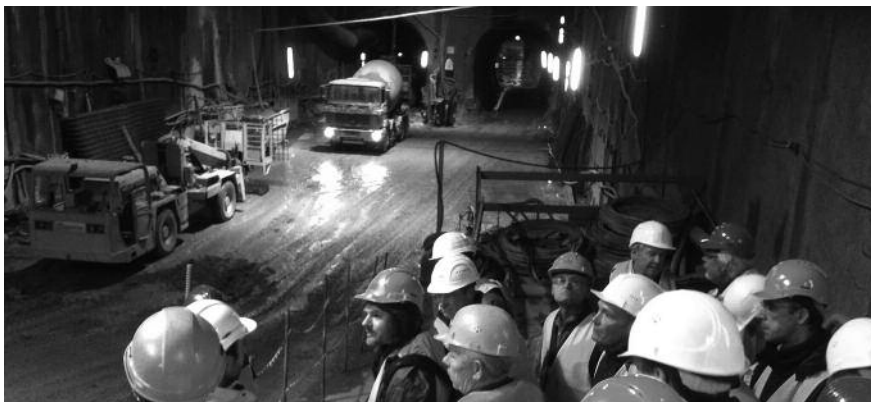
Baustellenbesichtigung der U3 in Nürnberg.
