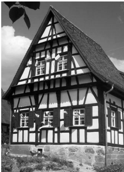
Dieses frühneuzeitliche Fachwerkhaus in Mistendorf wurde beim Bayerischen Denkmalpflegepreis 2008 mit einer Anerkennung ausgezeichnet. Foto: privat
