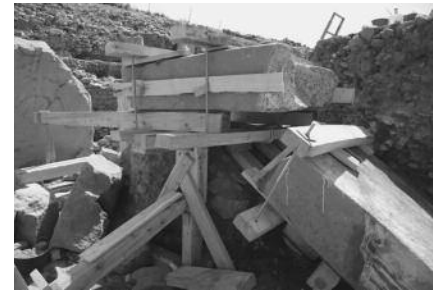
Umlegen des oberen Pfeilerteils mit Hebelkraft. Foto: E. Knoll
