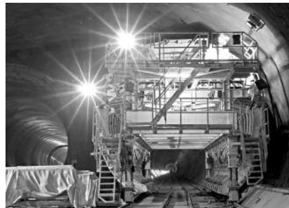
Schalwagen in der Tunnelwechsellaufrichtung Foto: AlpTransit Gotthard AG
