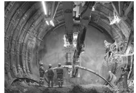
Einbau von Stahlbogen an der Tunnelbrust Foto: AlpTransit Gotthard AG
