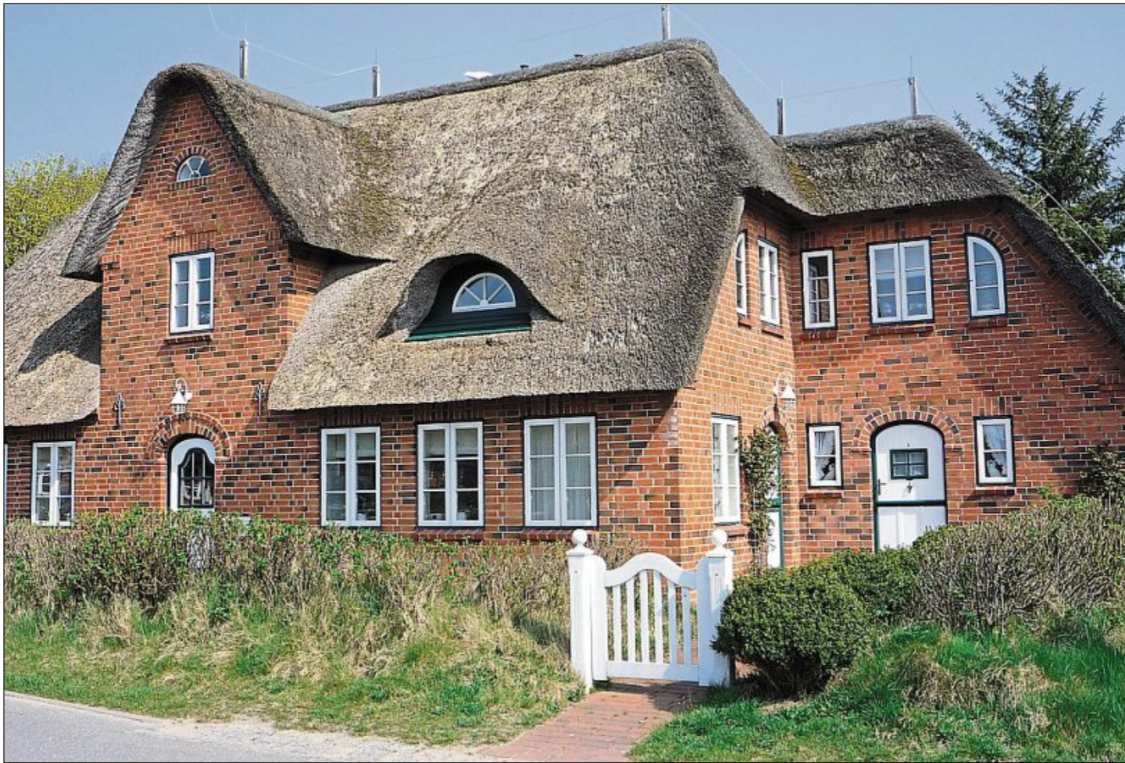
Ein Reetdach mit dem nachwachsenden Naturbaustoff Schilfrohr.
