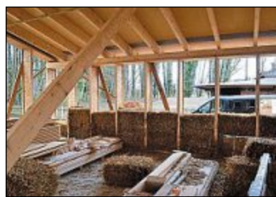
Strohballenhaus in Holzständer-Bauweise.
