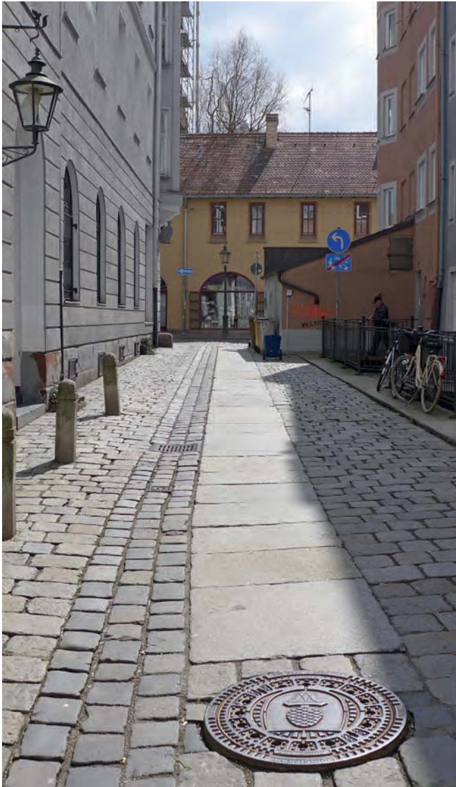
Abb. 36 Barrierefreiheit im öffentlichen Raum: Pflastergestaltung mit weitgehend ebener (Teil-)Oberfläche im historischen Ensemble, jedoch Kanaldeckel als Barriere (Foto: Bernd Vollmar)
