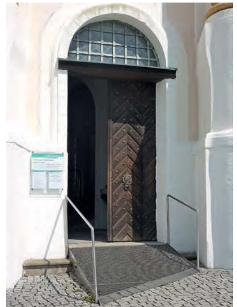
Abb. 45, 46 Barrierefreiheit am Baudenkmal (Welterbe): additive Rampe am Nebeneingang in Kombination mit behindertengerechten Parkplätzen – eine barrierefreie Erschließung des Haupteingangs war hier nicht möglich (Foto: Bernd Vollmar)
