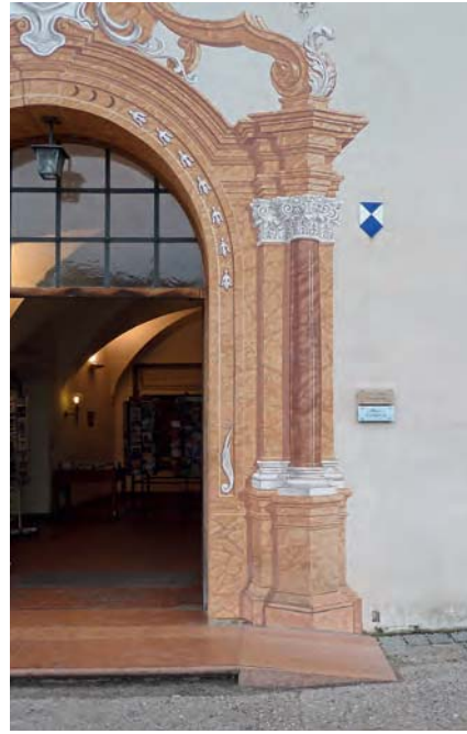
Abb. 55 Barrierefreiheit am historischen Bestand: Angleichung des Innen- und Außenniveaus unter Beibehaltung der historischen Schwelle als Kompromisslösung (Foto: Bernd Vollmar)
