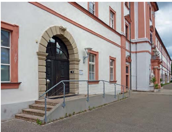
Abb. 63 Barrierefreiheit am Baudenkmal: moderner Ersatz der historischen Stufenanlage (Foto: Bernd Vollmar)
