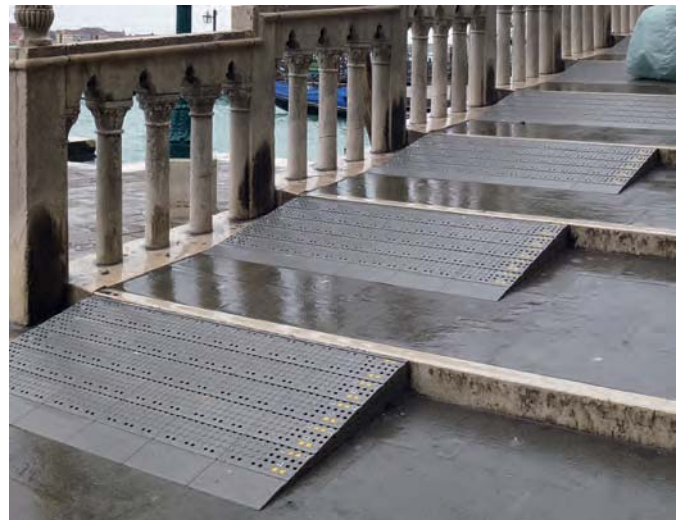
Abb. 7 Barrierefreiheit in der historischen Stadt: endgültige Kompromisslösung einer Rampe mit Anpassung der möglichen Rampenneigung an die örtlichen Gegebenheiten in Venedig (Foto: Bernd Vollmar)
