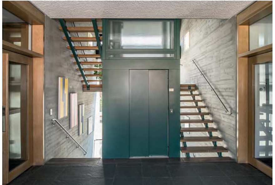
Abb. 75 Barrierefreiheit im denkmalgeschützten, öffentlichen Gebäude: Für den nachträglichen Einbau einer Aufzugsanlage im Treppenaue wurden die Treppenläufe erneuert (Foto: BLfD, Michael Forstner)
