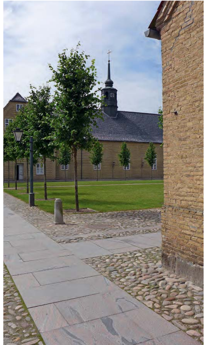
Abb. 37 Barrierefreiheit im öffentlichen Raum: Pflastergestaltung mit weitgehend ebener (Teil-)Oberfläche im historischen Ensemble, jedoch nicht angemessenem Material (Foto: Bernd Vollmar)
