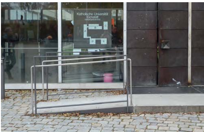
Abb. 57 Barrierefreiheit am modernen Bestandsbau: additiver Niveausausgleich (Foto: Bernd Vollmar)
