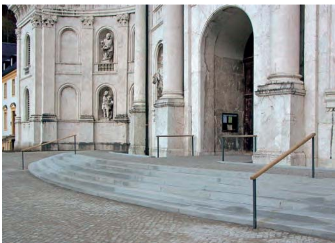
Abb. 47–49 Barrierefreiheit am Baudenkmal: Vorzustand des Kirchenportals (links oben) und Zustand nach der barrierefreien Erschließung: vorgelagerte Treppenneugestaltung mit integrierter Rampe. Das neue ebenerdige Niveau verdeckt den Sockelbereich des historischen Bestandes (Fotos: Bernd Vollmar)
