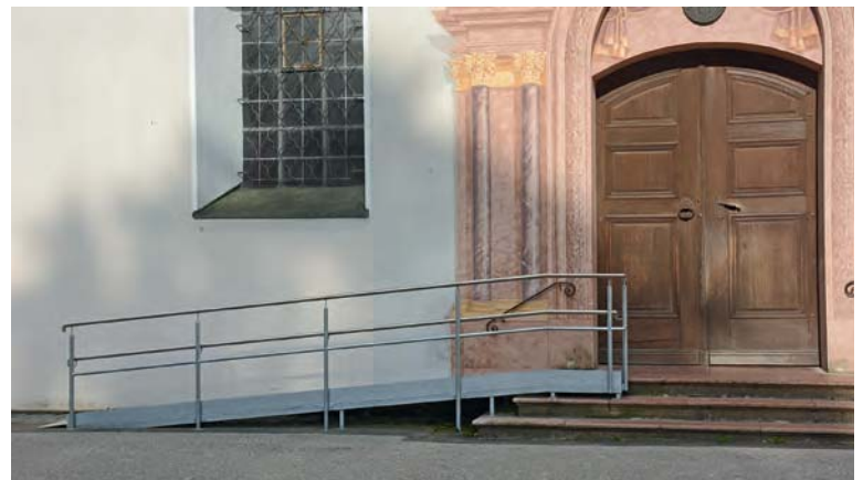
Abb. 52, 53 Barrierefreiheit am Baudenkmal: provisorische und endgültige Rampenlösung (Fotos: Bernd Vollmar, Klaus-Jürgen Edelhäuser)
