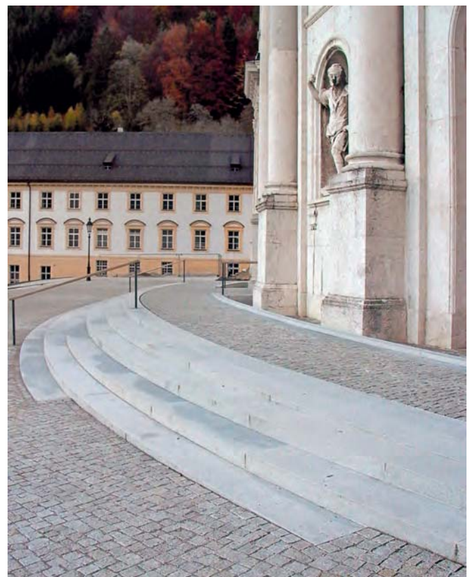
Abb. 47–49 Barrierefreiheit am Baudenkmal: Vorzustand des Kirchenportals (links oben) und Zustand nach der barrierefreien Erschließung: vorgelagerte Treppenneugestaltung mit integrierter Rampe. Das neue ebenerdige Niveau verdeckt den Sockelbereich des historischen Bestandes (Fotos: Bernd Vollmar)
