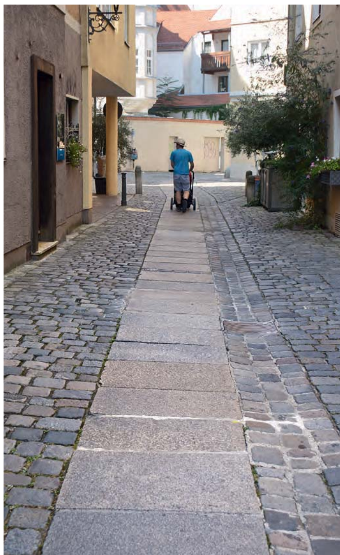
Abb. 34 Barrierefreiheit im öffentlichen Raum: Pflastergestaltung mit ebener (Teil-)Oberfläche im historischen Ensemble (Foto: Klaus-Jürgen Edelhäuser)
