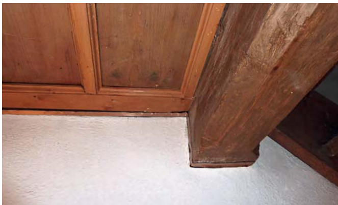
Abb. 25 Barrierefreiheit im kirchlichen Bereich: „induktive Schleife“, verlegt an einer historischen Deckenkonstruktion (Foto: Klaus-Jürgen Edelhäuser)
