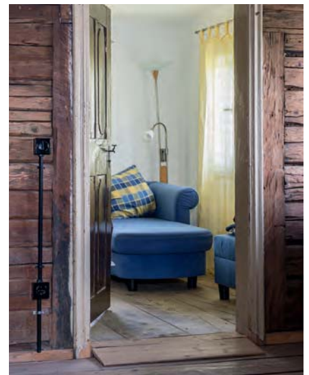
Abb. 85 Schwellen-Niveausgleich mit Abschrägung als Kompromisslösung (Foto: BLfD, Michael Forstner)
