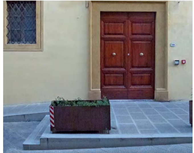
Abb. 11 Barrierefreiheit in der historischen Stadt: Rampen- und Stufenlösung als Ersatz für die bauzeitliche Erschließung (Foto: Bernd Vollmar)
