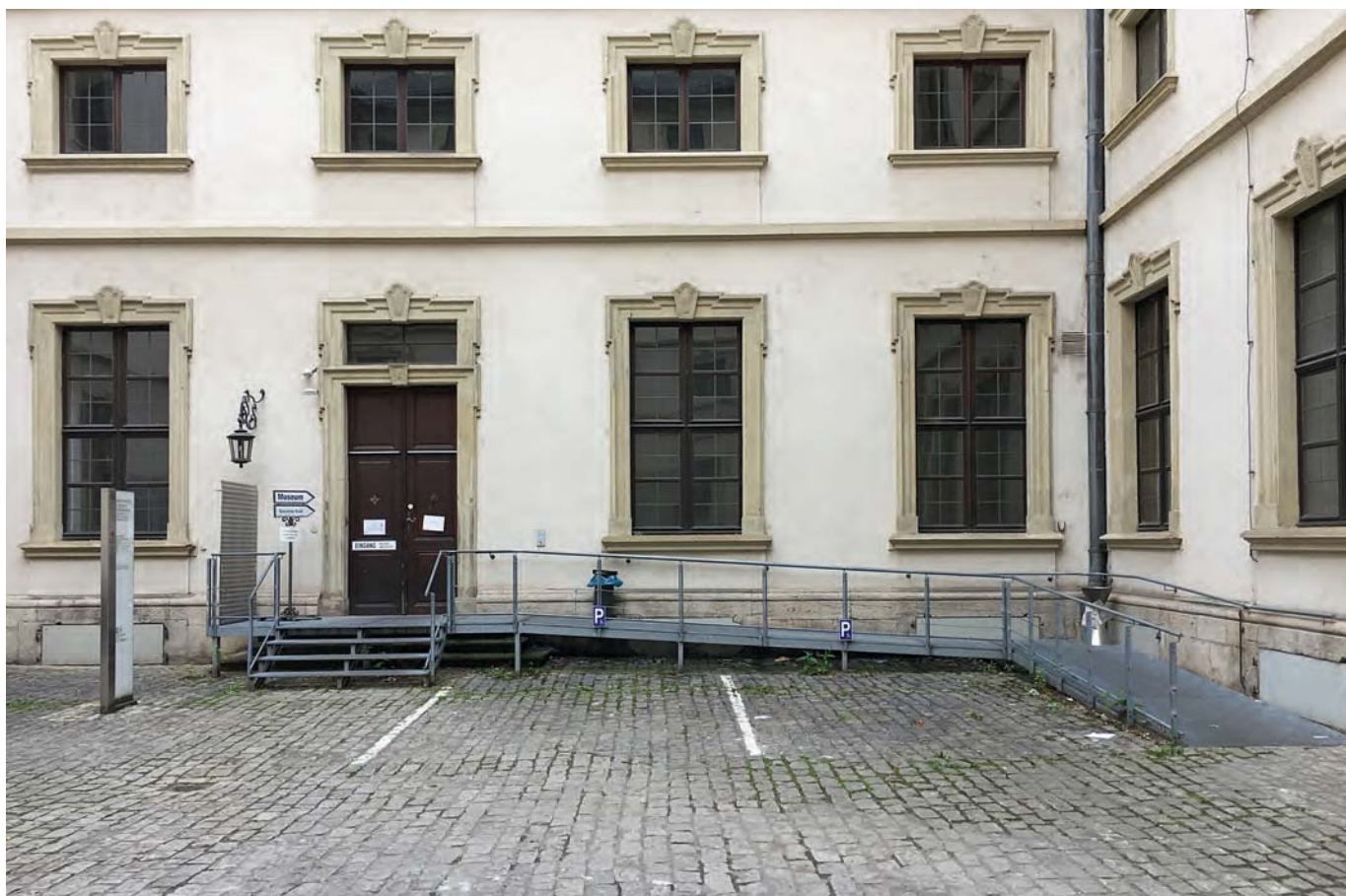
Abb. 23 Barrierefreiheit im musealen Bereich: additive Rampe im nicht einsehbaren Innenhofbereich in Kombination mit barrierefreien Parkplätzen – die barrierefreie Erschließung des Haupteingangs war hier nicht möglich (Foto: Bernd Vollmar)
