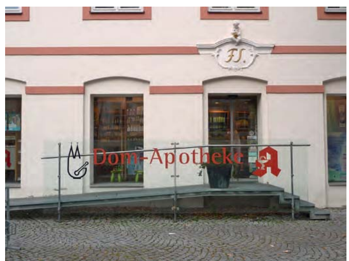
Abb. 64 Barrierefreiheit im öffentlichen Bereich: moderner Ersatz der historischen Stufenanlage (Foto: Bernd Vollmar)
