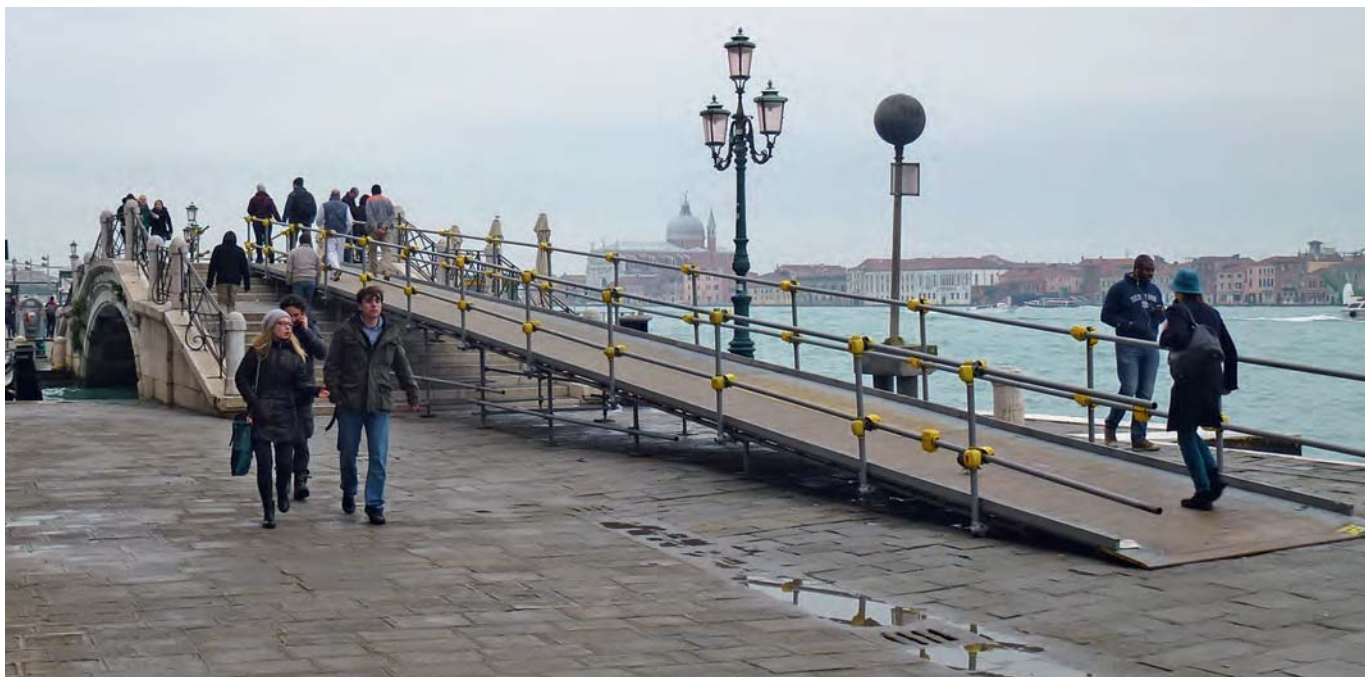
Abb. 4 Barrierefreiheit in der historischen Stadt: provisorische Rampenlösung in Venedig (Foto: Bernd Vollmar)
