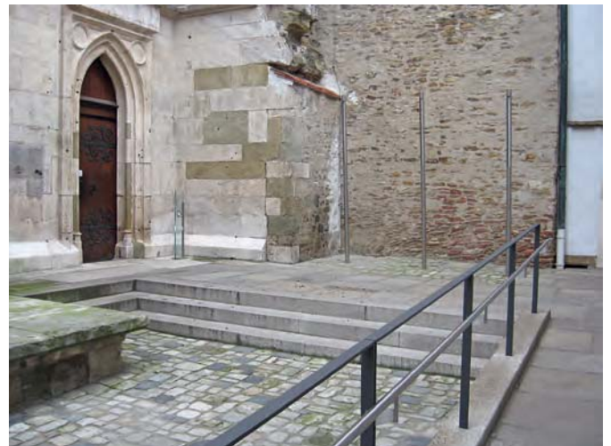
Abb 41–43 Barrierefreiheit am Baudenkmal: Die Westfassade mit Figurenportalen und Treppensockel sind mit einer modernen Rampen- oder Aufzugsanlage nicht vereinbar – der barrierefrei Zugang ist im Chorbereich möglich und ausgeschildert (Fotos: BLfD, Michael Forstner, Bernd Vollmar, Schild o. re. http://www.holicap.de/Ausflugsziele/Oberpfaelzer-Wald/Regensburg-Dom-St.-Peter-in-Regensburg.html )
