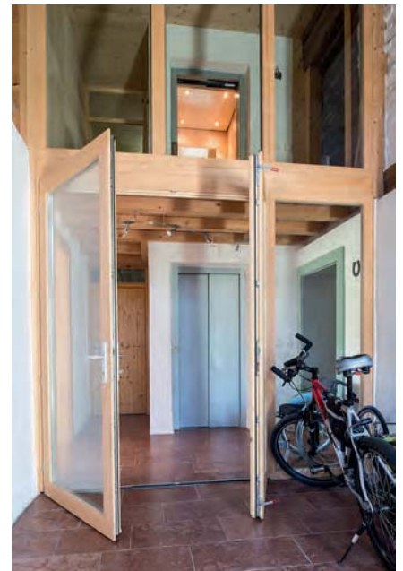
Abb. 83 Interne Aufzugserschließung des Ober- und Dachgeschosses (Foto: BLfD, Michael Forstner)
