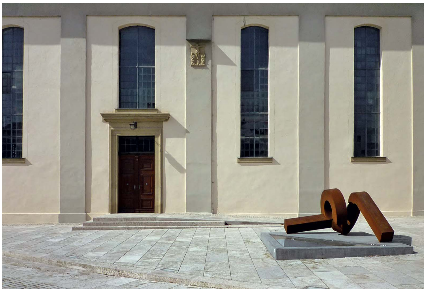
Barrierefreiheit am Baudenkmal: eine in die Treppenstufen und in die Oberflächengestaltung des Platzes integrierte Rampe, gegenläufig zur Geländeneigung (Foto: Bernd Vollmar)
