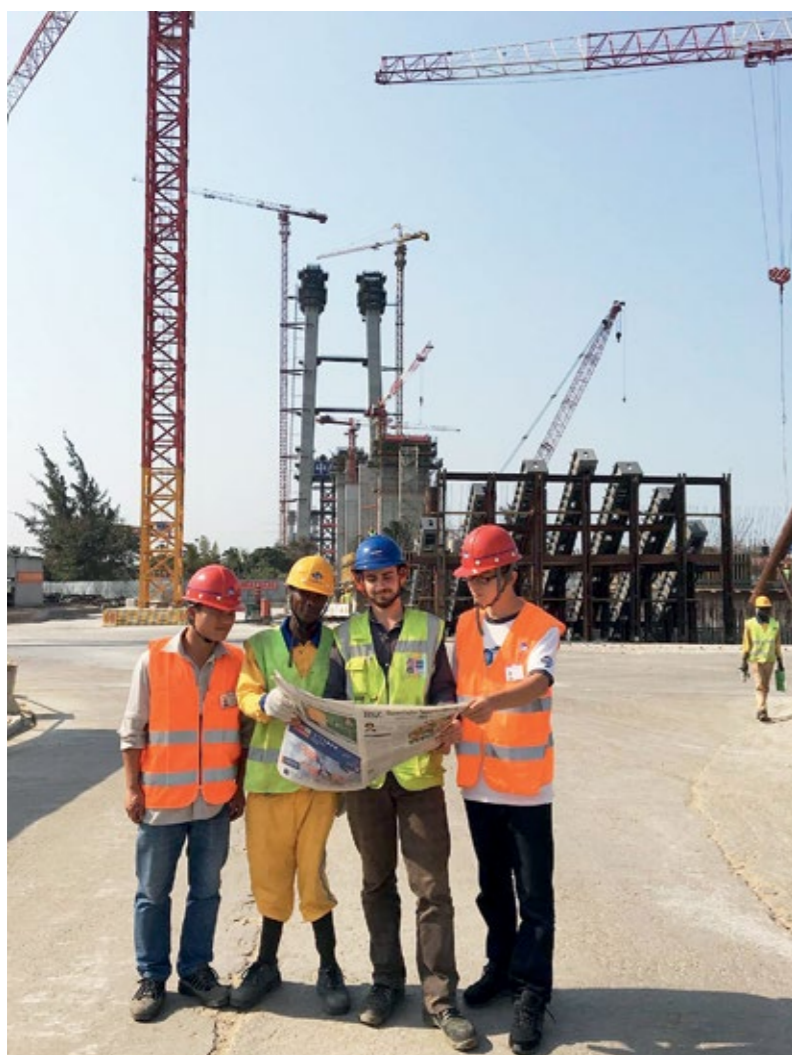
Bau der Maputo Bridge in Mosambik
