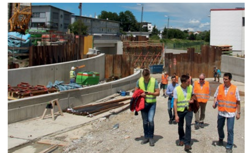
Teilnehmer des Traineeprogramms auf der Baustelle
