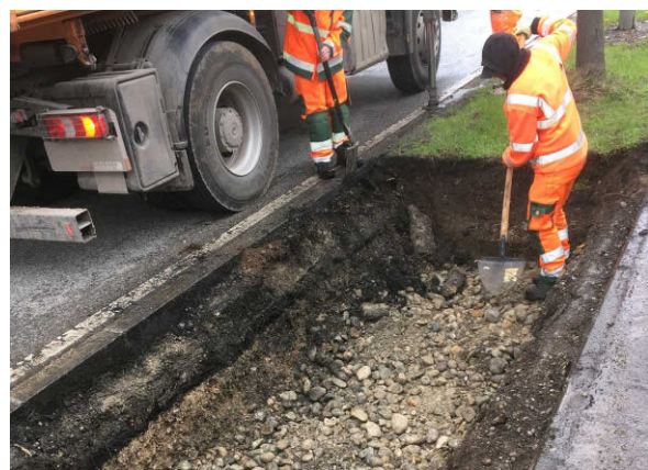
Abb. 9: Modellierung des Unterbodens für die geplante Versickerungsmulde
