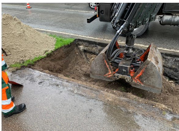
Abb. 8: Aushub für eine straßenbegleitende Versickerungsmulde (im Bestand)
