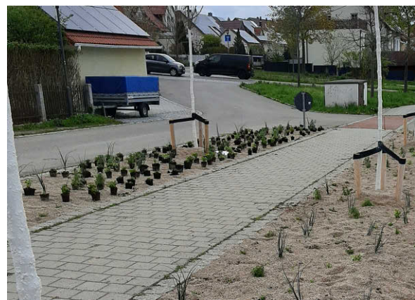
Abb. 13: Pflanzung von vorgezogenen Stauden (erkennbar ist die überhöhte Mächtigkeit des Substrats zum Zeitpunkt der Pflanzung, da noch eine Setzung des Bodenaufbaus von 10 – 20 % erwartet wird)
