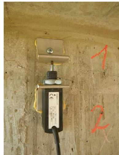
Bild 3: Wegaufnehmer zur Erfassung der Rissbreite (Foto: MKP GmbH)
