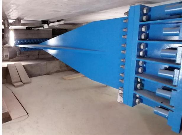
Bild 19: Federlamelle zur Längsfesthaltung (Foto: MKP GmbH)
