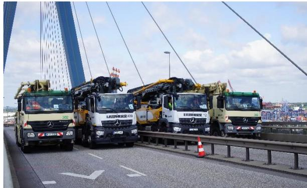
Bild 17: Betonpumpen als Belastungsfahrzeuge auf der Köhlbrandbrücke (Foto: MKP GmbH)
