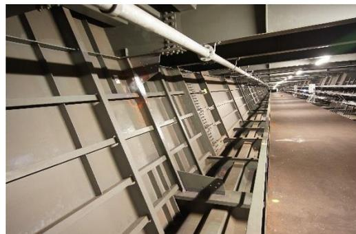
Bild 14: Blick ins Innere des Stahl-Hohlkastens mit Querrahmen vor Sanierung (Foto: MKP GmbH)
