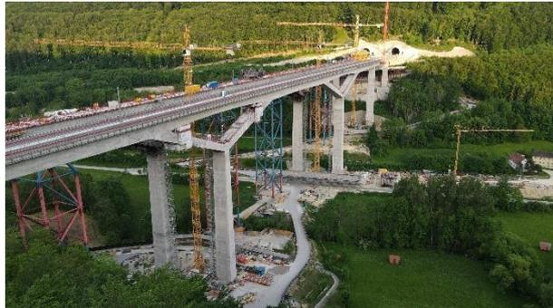
Bild 18: Die Filstalbrücken im Bau (Foto: MKP GmbH)
