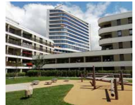
Büro- und Hotelhochhaus NEO, Baumkirchen Mitte
