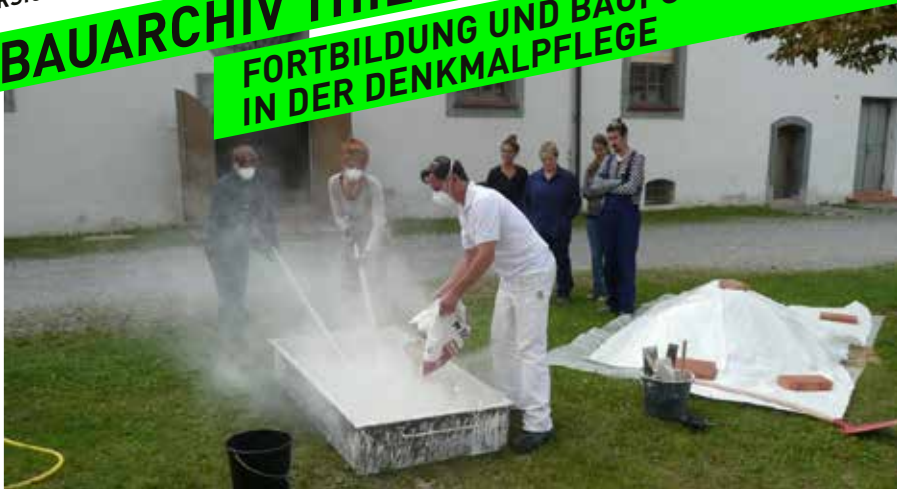
Intensivwoche Bauarchiv Thierhaupten: Löschen des Brandkalkes. Die dabei entstehende Hitze führt zur Bildung von Wasserdampf
