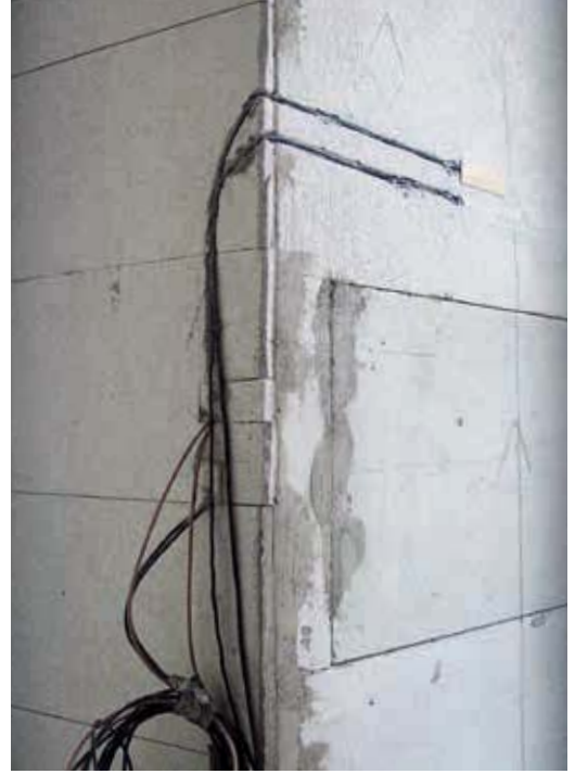
Herrenschießhaus, Untere Talgasse 8, Nürnberg, Einbau von Innendämmung mit Messfühler unter der Dämmung. Bild: Stadt Nürnberg
