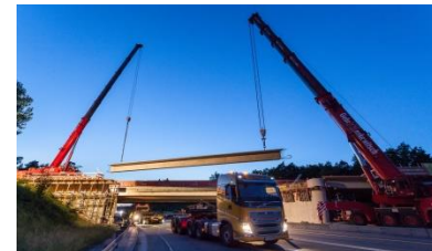
BAB A3, Frankfurt-Nürnberg Teilerneuerung Überführung
