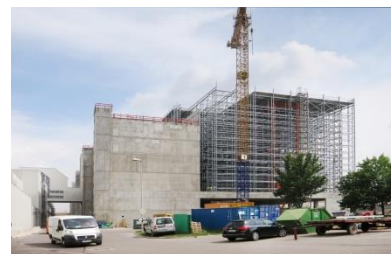
Neubau Hochregallager, Audi AG, Ingolstadt
