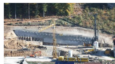
Hotel-Sponsel-Regus, Heiligenstadt, Baugrubensicherung
