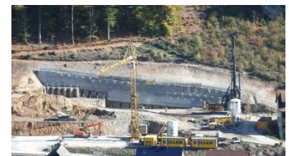
Hotel-Sponsel-Regus, Heiligenstadt, Baugrubensicherung
