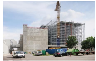
Neubau Hochregallager, Audi AG, Ingolstadt
