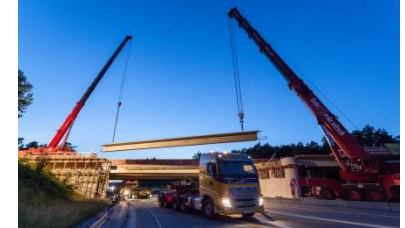
BAB A3, Frankfurt-Nürnberg Teilerneuerung Überführung
