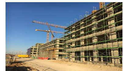
Neubau Bürogebäude, GfK, Nürnberg
