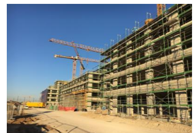
Neubau Bürogebäude, GFK, Nürnberg
