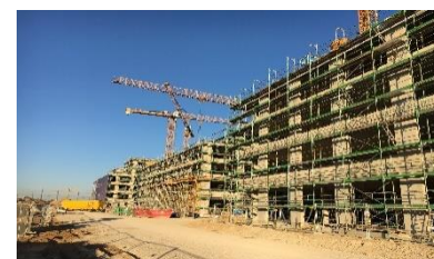
Neubau Bürogebäude, GFK, Nürnberg
