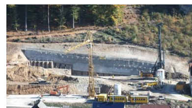
Hotel-Sponsel-Regus, Heiligenstadt, Baugrubensicherung
