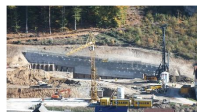
Hotel-Sponsel-Regus, Heiligenstadt, Baugrubensicherung
