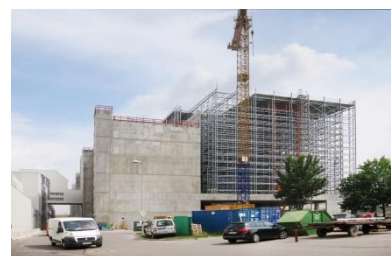
Neubau Hochregallager, Audi AG, Ingolstadt
