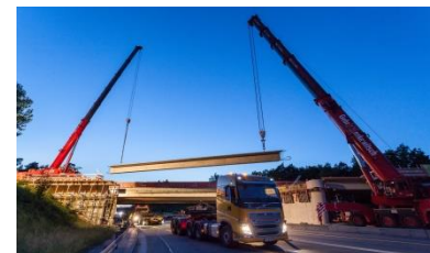
BAB A3, Frankfurt-Nürnberg Teilerneuerung Überführung
