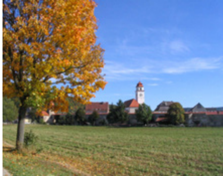
Das Nahwärmenetz in Dollnstein hat eine Wärmeleistung von rund 1.400 kW.
