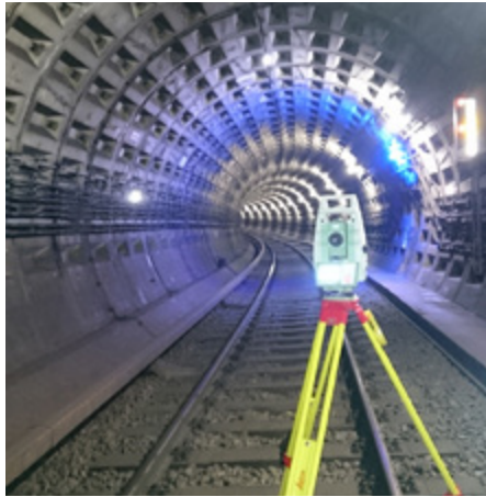
Ingenieure und Geologen arbeiten eng zusammen.
