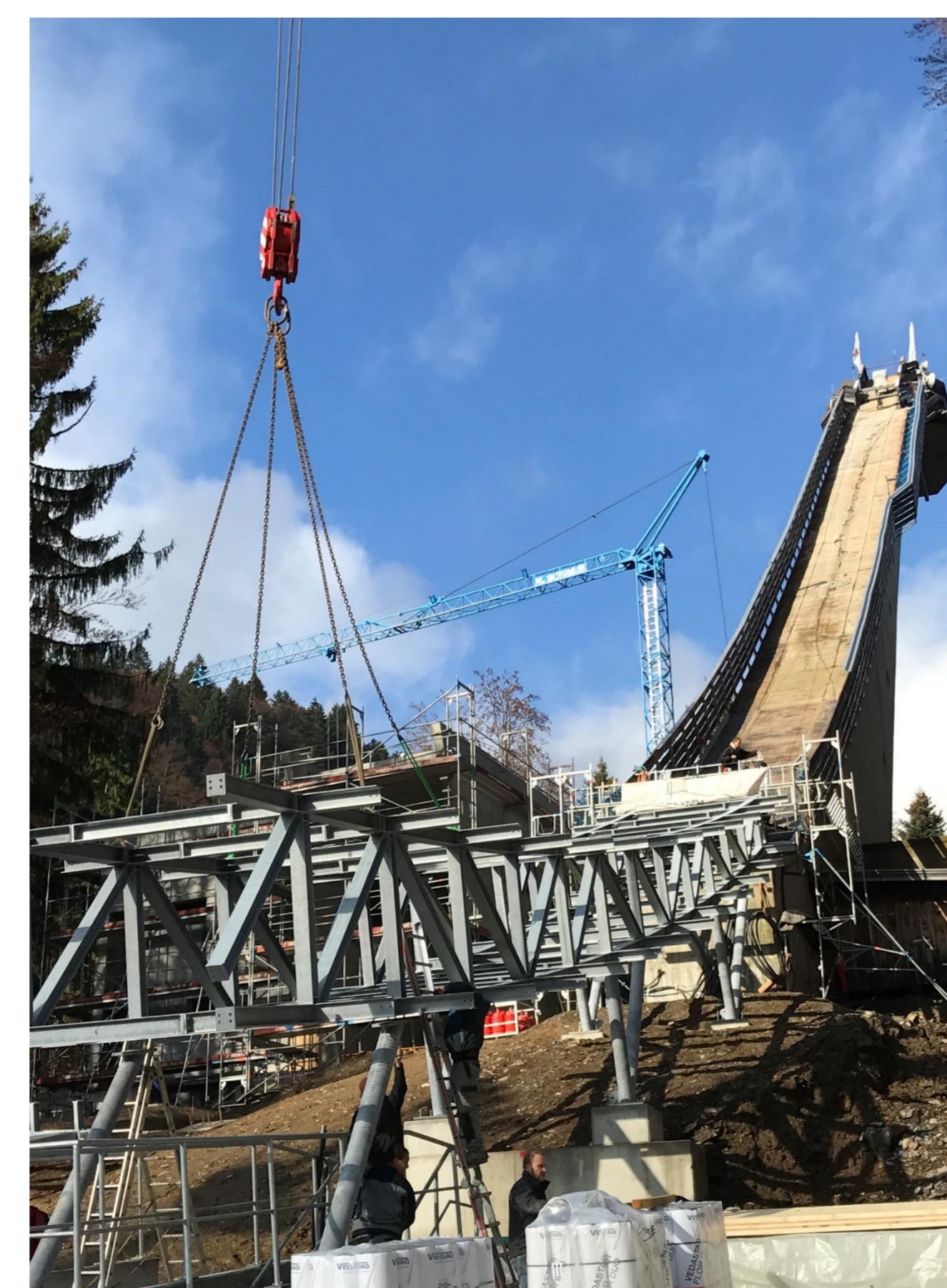
Montage der Stahlkonstruktion © Renn Architekten
