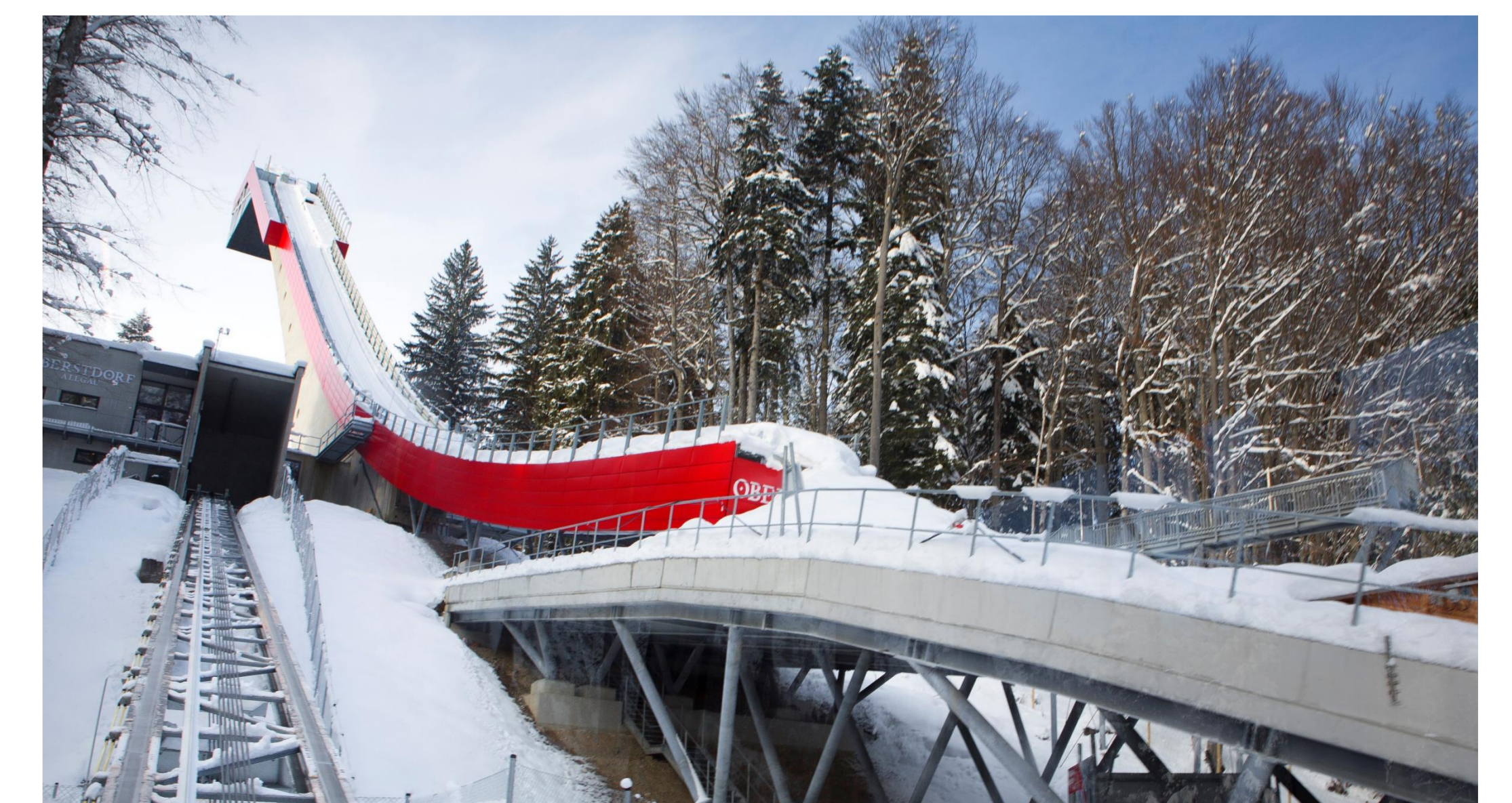
Schanzentisch mit Anlaufbauwerk Konstruktionsgruppe Bauen AG © Eva Bartsussek
